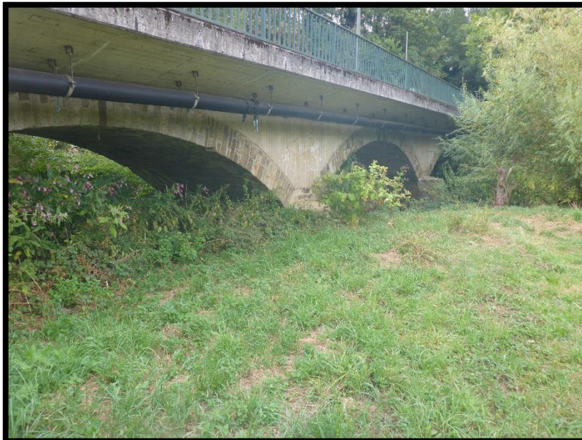
Brücke Waldstraße von oberstrom
