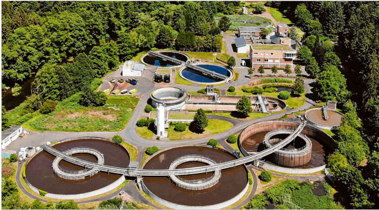
Läuft alles nach Plan, steht 2021 auf dem Areal des Klärwerks in der Muhlau eine Klärschlammverbrennungsanlage, in der der gesamte Schlamm aus dem Kreis Altenkirchen verfeuert werden soll.
